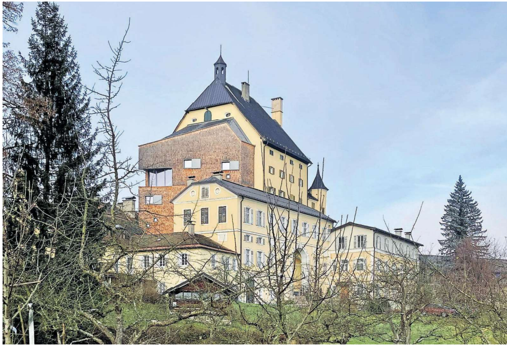
An der Südseite des Turmes wurde vor zwei Jahren ein groß dimensioniertes Fluchtstiegenhaus zugebaut. (Judith Eiblmayr)
